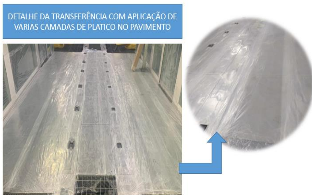
Figura 09 - Detalhe da transferência entre as cabines
